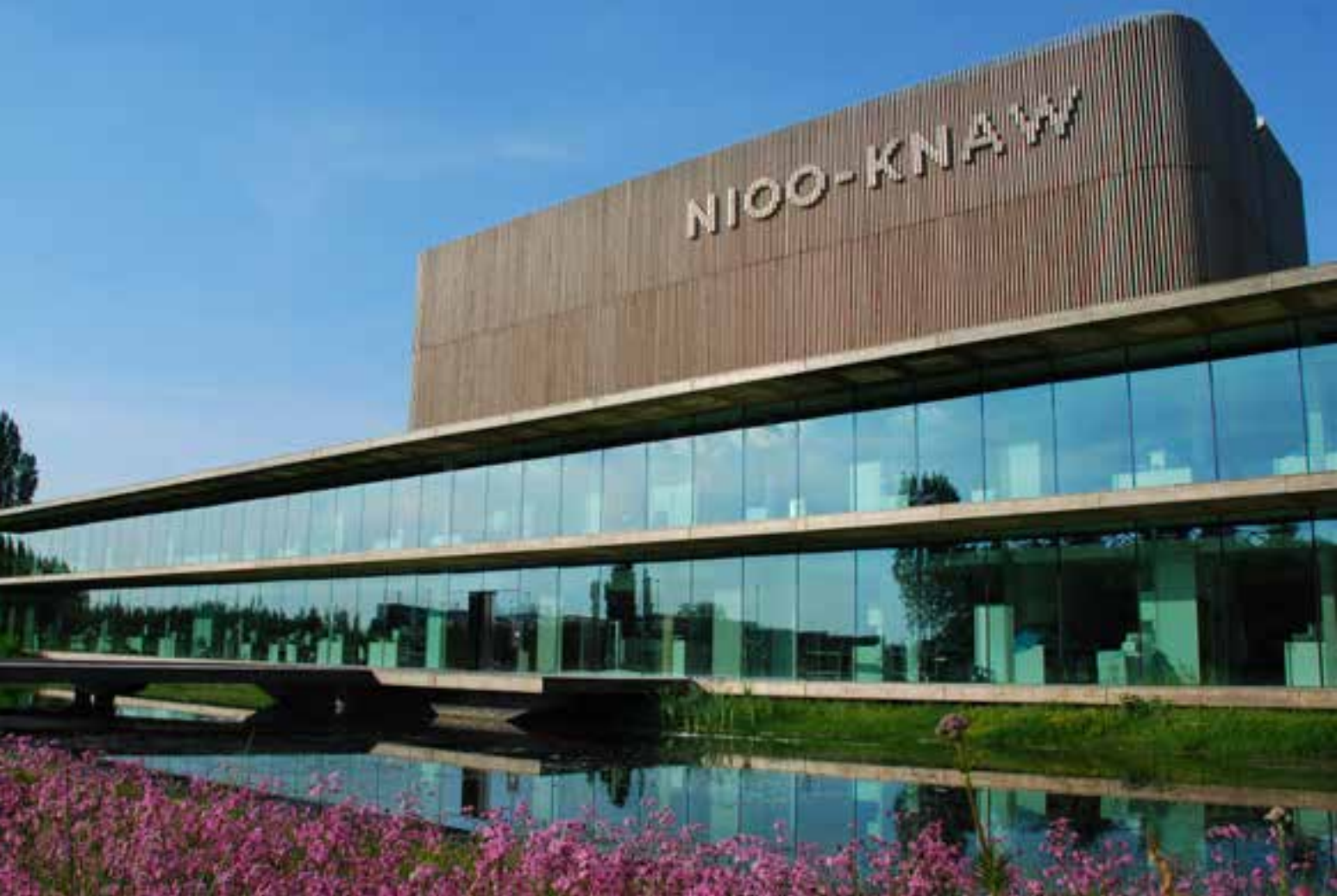
Het Nederlands Instituut voor Ecologie (NIOO-KNAW) huist in een bijzonder duurzaam gebouw uit 2011
