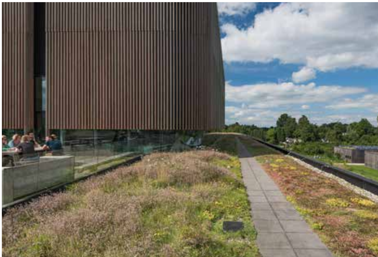
Op het groene dak van het NIOO werden afgelopen voorjaar vijftig soorten planten geteld
